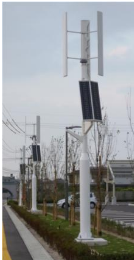
小型風力発電付街路灯
